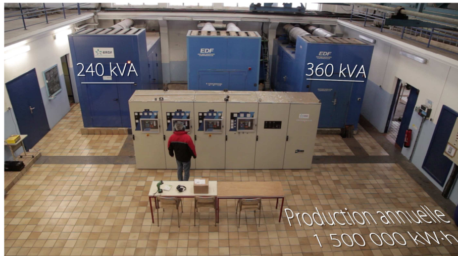
Les groupes électrogènes du phare de l'île de Sein
