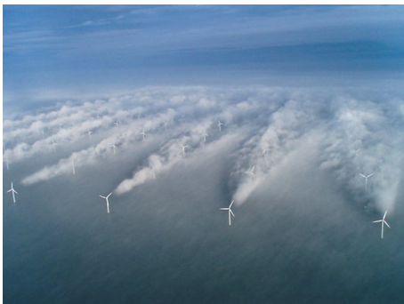
Figure: Horns rev offshore wind farm, Vattenfall, 2008
