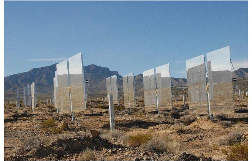
« Les vent, parfois violents, apporteurs de sable, détruisent les miroirs ou grippent la mécanique d'orientation, et déposent leurs poussières sur les miroirs, baissant leur rendement. »
