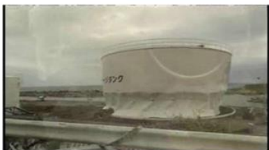
Bâche d'effluents déformée près de la SdP tr 5
