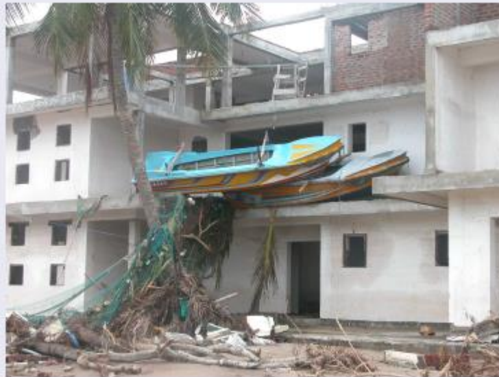
Exemple de dégâts liés au tsunami du 26 décembre 2004 au Sri Lanka
